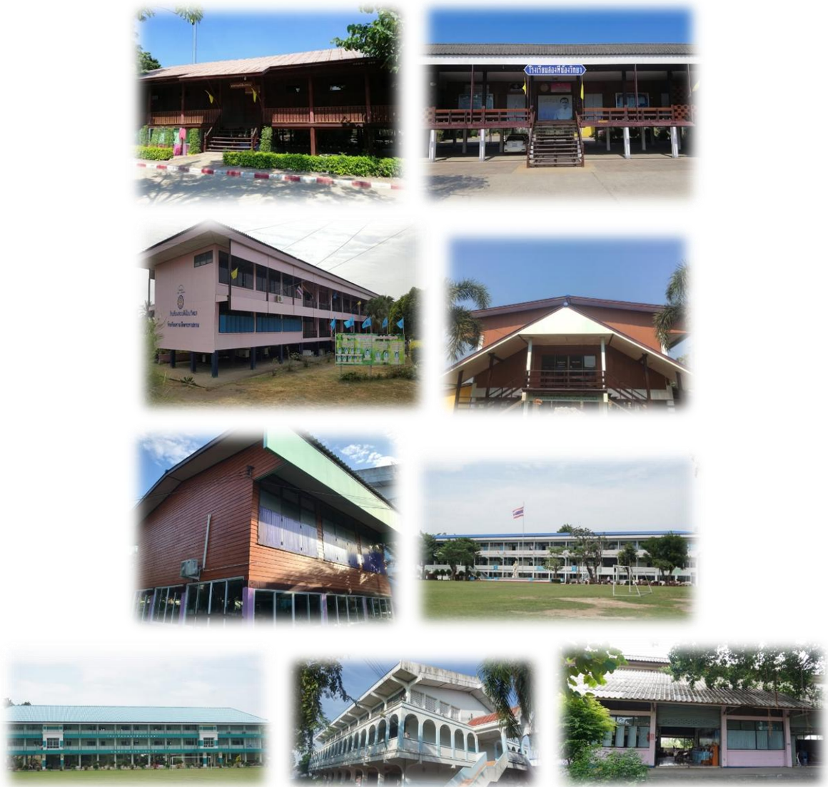
อาคารภายในบริเวณโรงเรียน
